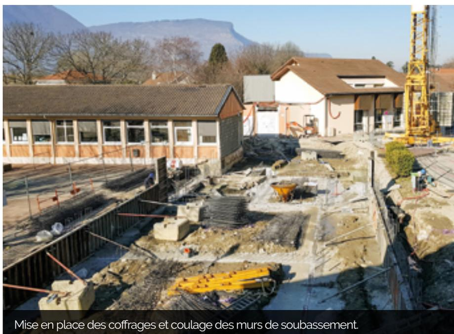
Mise en place des coffrages et coulage des murs de soubassement.
