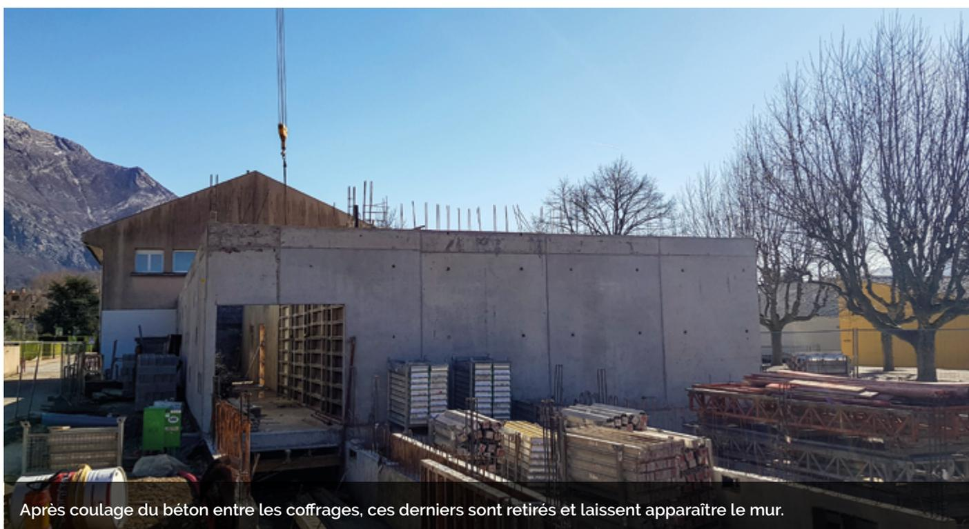
Après coulage du béton entre les coffrages, ces derniers sont retirés et laissent apparaître le mur.
