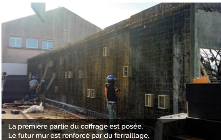
La première partie du coffrage est posée. Le futur mur est renforcé par du ferrailage.
